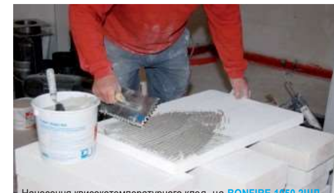
Нанесення квисокотемпературного клея на BONFIRE 1050,2ШЛ
