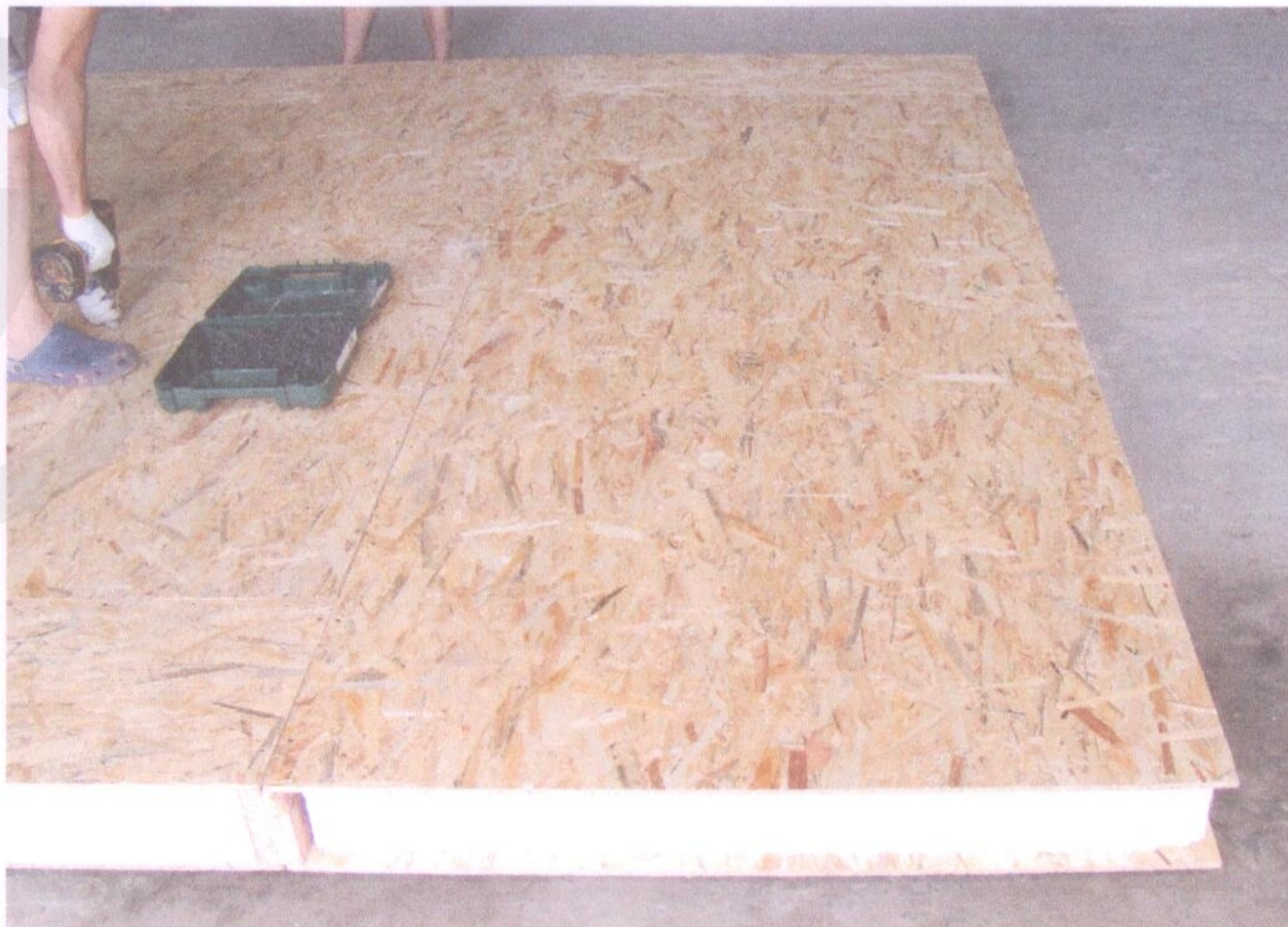
Вигляд монтажу зразків
