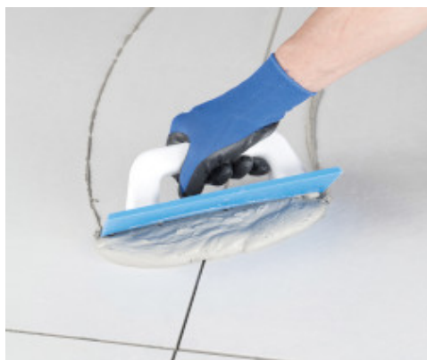
Нанесення матеріалу гумовим шпателем на облицювану підлогу
