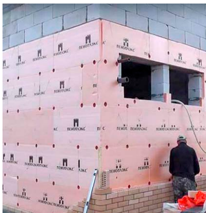
РОЗМІЩЕННЯ ВЕНТИЛЯЦІЙНО-ВОЛОГОВІДВІДНИХ ОТВОРІВ НА ПОВЕРХНІ ФАСАДУ
